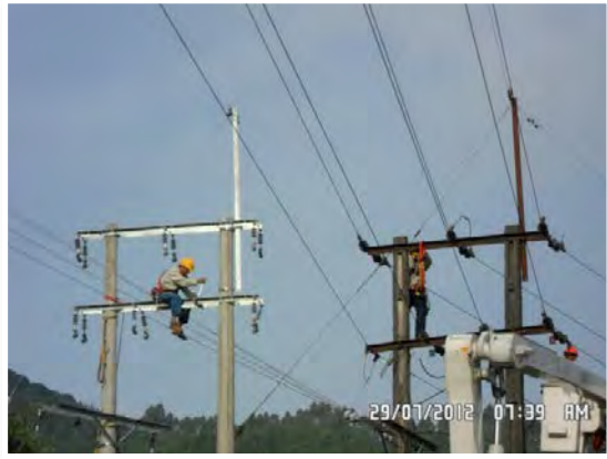
Remodelación circuito a 13.2 kV vía Panamericana. Sector la Playita
