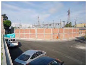
Obras civiles S/E Manizales Patio de 33kV
