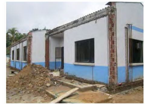
Obras civiles reforzamiento estructural subestación Riosucio
