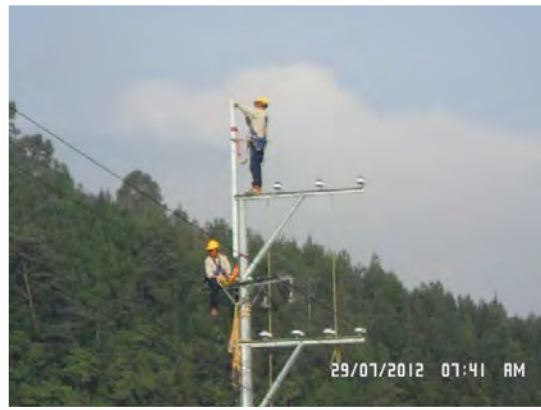
Remodelación circuito a 13.2 kV vía Panamericana. Sector la Playita
