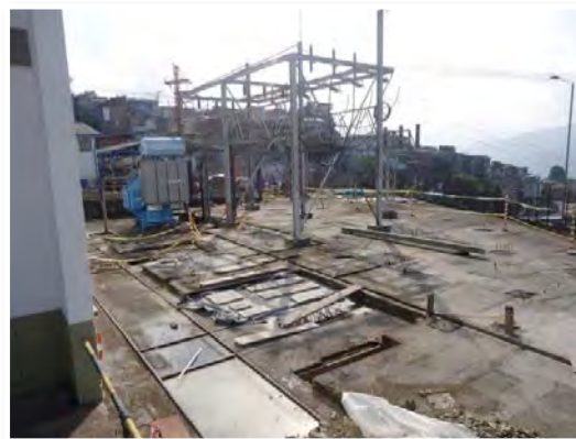
Obras civiles subestación Viterbo
