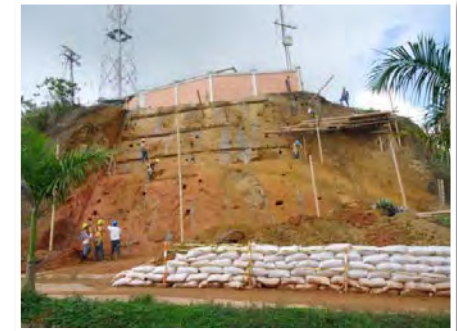
Obras civiles estabilización Talud Éste subestación Belalcazar
