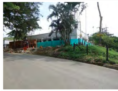
Obras civiles subestación Viterbo
